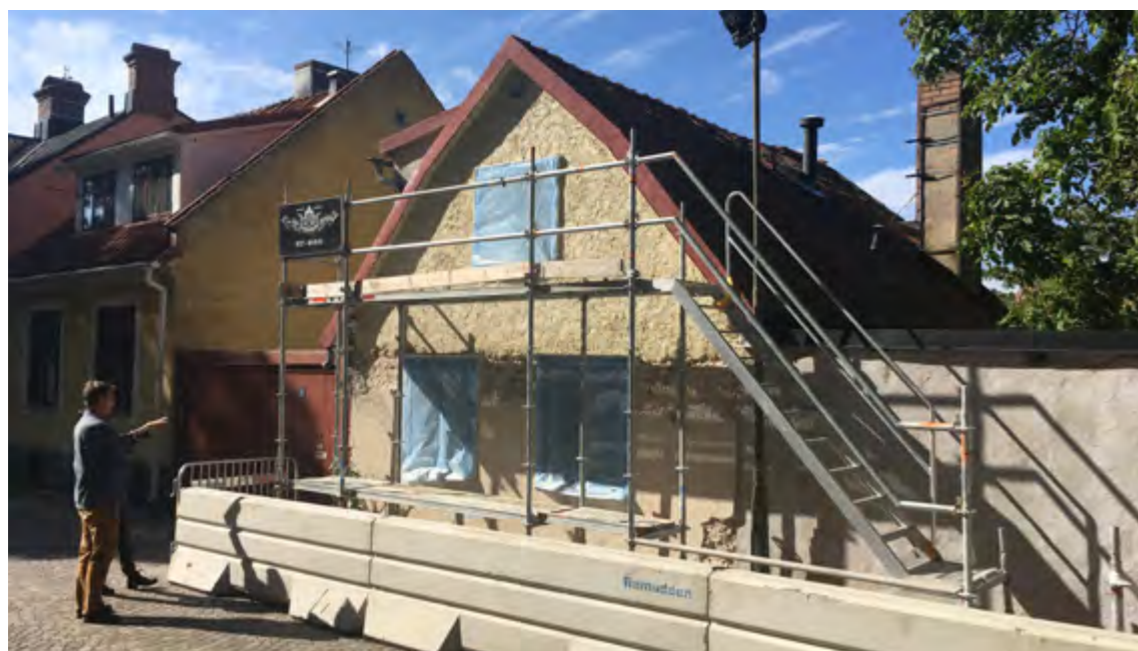
Isolering med hampkalk i Visby innerstad.
